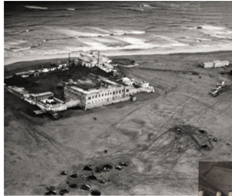
Vue aérienne de Cap Juby, aéroplace de l'Aéropostale qu'a dirigée Antoine de Saint Exupéry en 1927 - 1928 : on y distingue bien le fort espagnol (Juby est alors situé dans ce qu'on appelle le Rio de Oro, sous domination espagnole) coincé entre mer et désert et le hangar pour avion. ©Archives Fondation Latécoère
